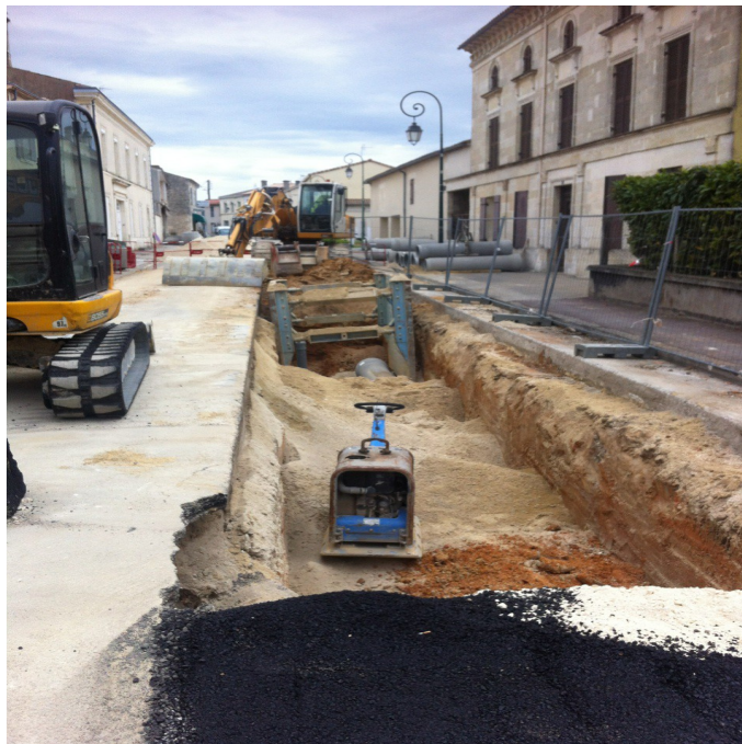
Situation du chantier avenue André Lafon
